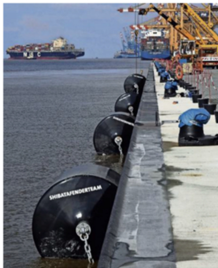
Der erste Liegeplatz der neuen Columbuskaje ist fertig. Die Bauarbeiten gehen aber weiter (linkes Bild). Schutz für Schiffe und Kaje: Die großen Gummifender hängen bereits. Sie halten die Schiffe auch auf Abstand, damit Kräne ihre Ladeluken erreichen können.
