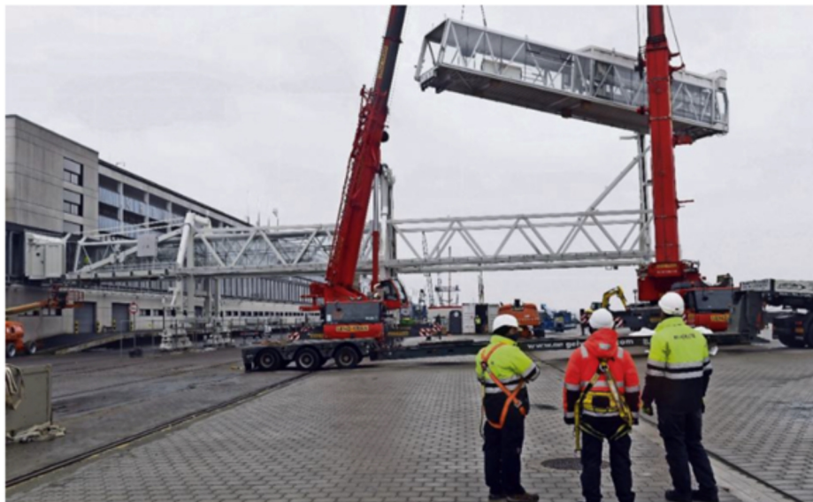
Startklar auch für die größten Schiffe: Der gläserne Passagiertunnel wird in die Stahlkonstruktion eingehängt.
